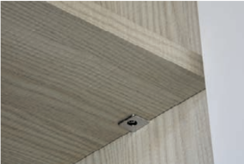
DETALLE DE EXCÉNTRICA DE UNIÓN (O ENSAMBLAJE).
